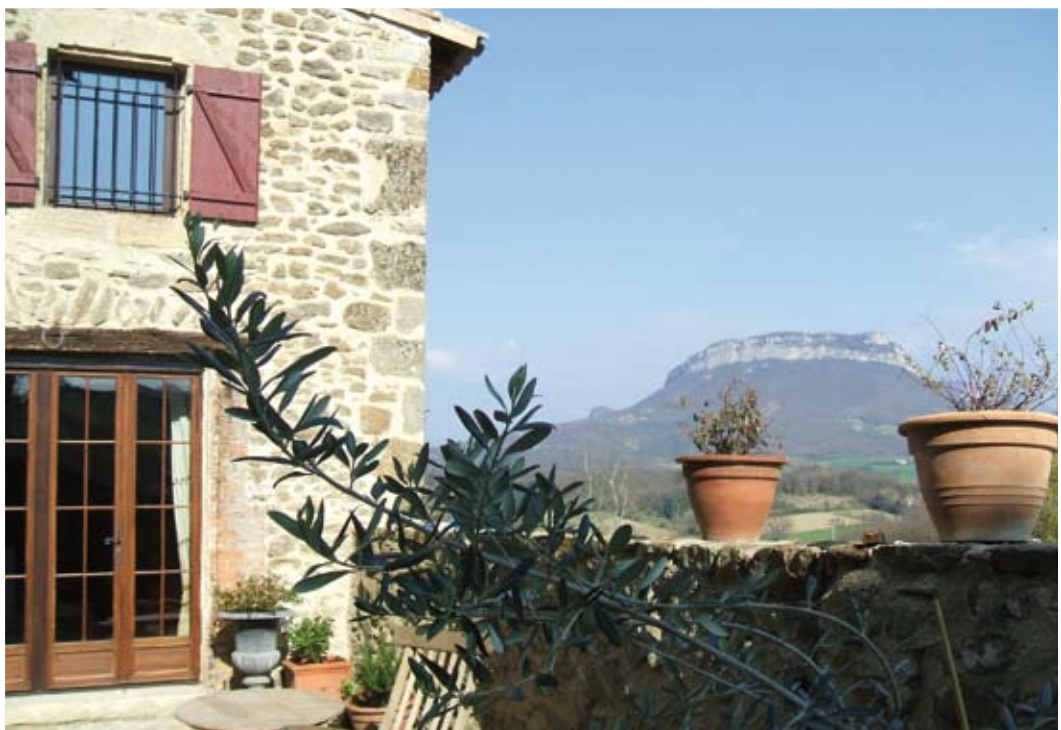
Gîte de la diligence après rejointoiment.
