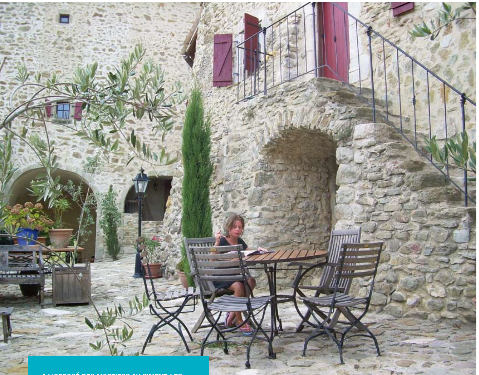
Murs, escaliers et calade rejointoyés à la chaux au Château de Combet (Drôme)
